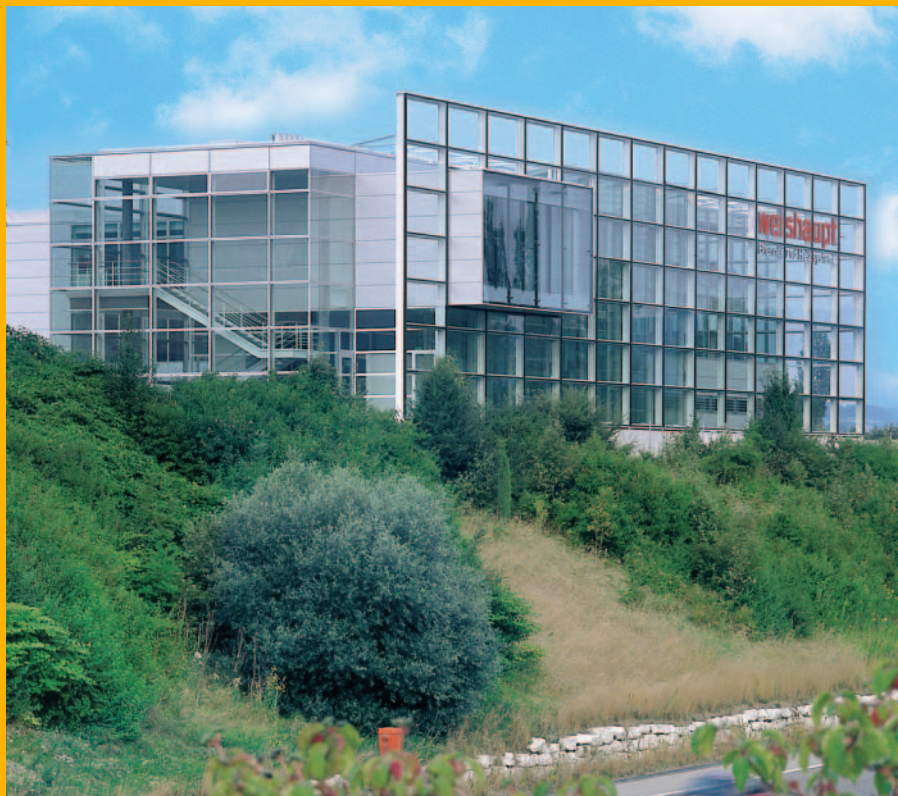
Neues Schulungs- und Verwaltungsgebäude in Geroldswil (ZH)
